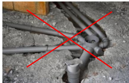
Bron: verbouwers.be Bouwfit dag 2 Renovatie
