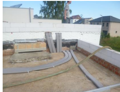
in hellingsbeton plat dak (onder isolatie!)
