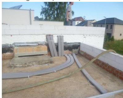
in hellingsbeton plat dak (onder isolatie!)
