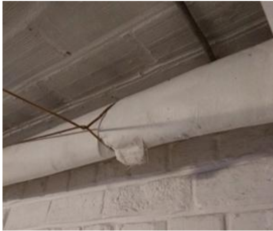
gipspleister rond isolatie verwarmingsbuizen
