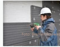
STAP 2 Boor gaten in de isolatieplaten.
