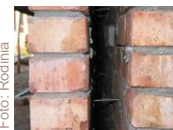
niet-geïsoleerde spouwmuur
