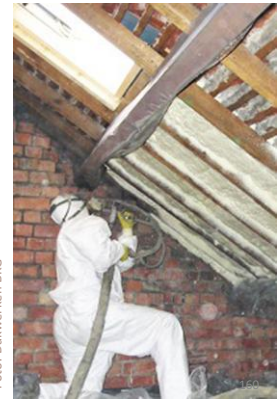
Foto: Dakwerken BKG
