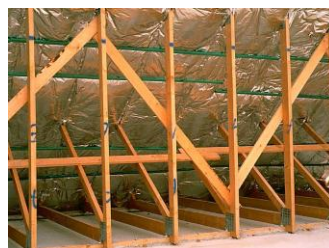
Bouwfit - Dag 1 renovatie
