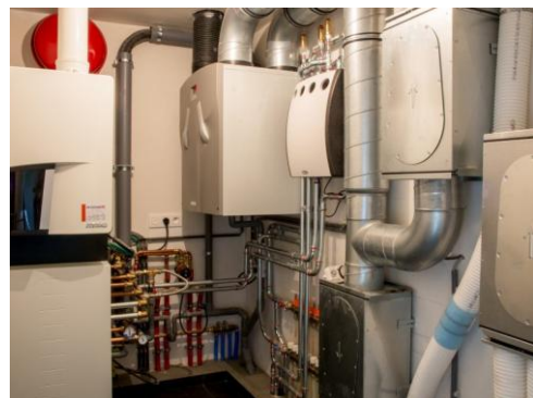
Technische ruimte met combi-warmtepompboiler en ventilatiesysteem
