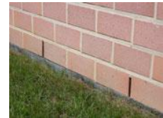
Spouwmuur met open stootvoegen en waterkerende laag
