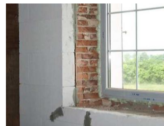
Isolatie dagkanten niet vergeten
