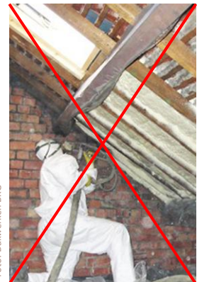
Foto: Dakwerken BKG
