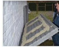
STAP 1 Plak de isolatiepanelen met mortellijm tegen uw gevel.
