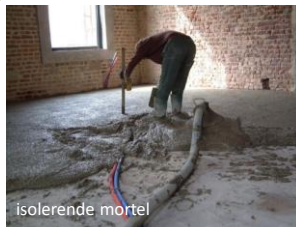
Bouwfit - Dag 1 renovatie
