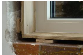
Binnenpleister = luchtdichtheid muren
