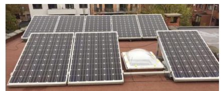
Foto: Smekens Dakwerken
