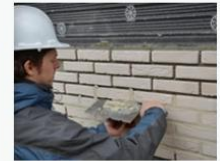
STAP 6 Voeg de bakstenen op.
