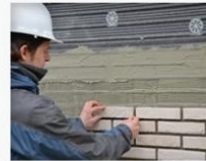
STAP 5 Plaats de steenstrips op de gelijmde isolatiepanelen.
