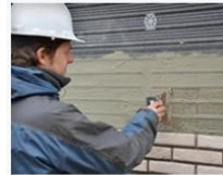
STAP 4 Brengh waterwerende lijm aan op de voorzijde van de isolatiepanelen en kam de lijm.
