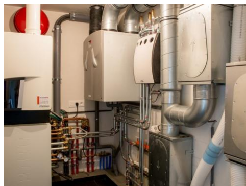
Technische ruimte met combi-warmtepompboiler en ventilatiesysteem
