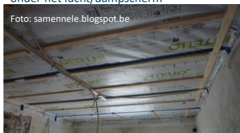
leidingen in leidingenspouw onder het lucht/dampscherm
