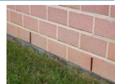
Spouwmuur met open stootvoegen en waterkerende laag
