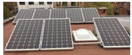
Foto: Smekens Dakwerken
