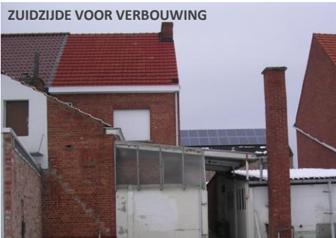
ZUIDZIJDE VOOR VERBOUWING
