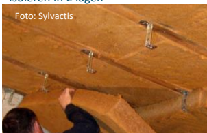
isoleren in 2 lagen
