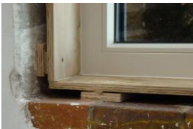
Binnenpleister = luchtdichtheid muren
