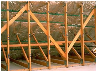
Bouwfit - Dag 1 renovatie
