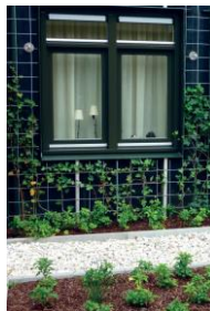
Bouwfit - Dag 1 Nieuwbouw
