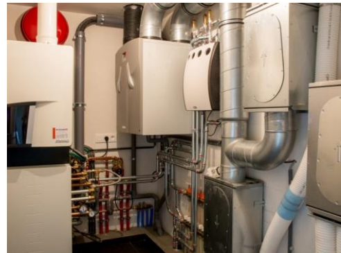
Technische ruimte met combi-warmtepompboiler en ventilatiesysteem
