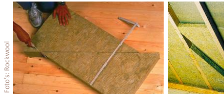
Bouwfit - Dag 1 Nieuwbouw
