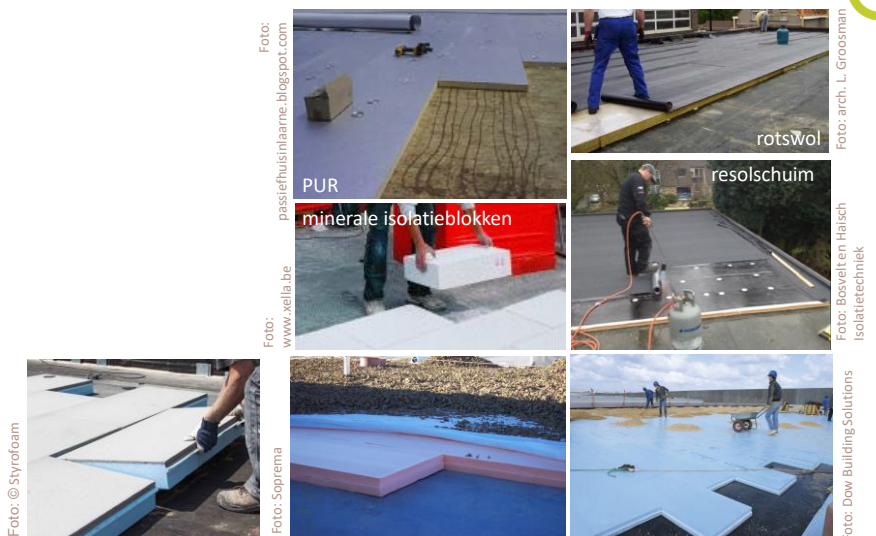
Bouwfit - Dag 1 Nieuwbouw
