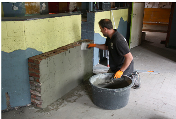
Testmuurtje met kalkcementmortel.
