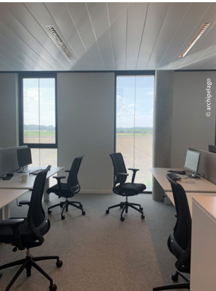
Drievoudige beglazing met permanente tussenzonwering.
