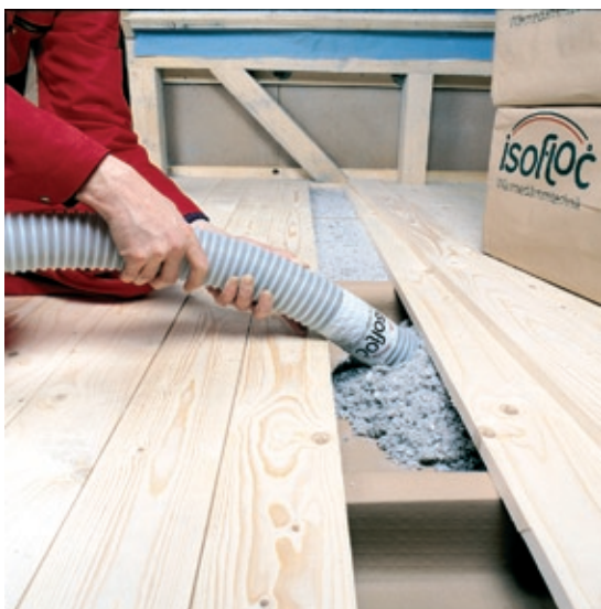
ZOLDERVLOER ISOLEREN MET VLOKKEN. FOTO © ISOFLOC
