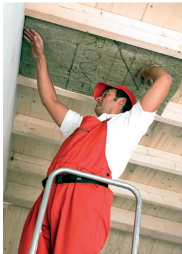
ISOLATIE TUSSEN DRAAGSTRUCTUUR. FOTO © ROCKWOOL
