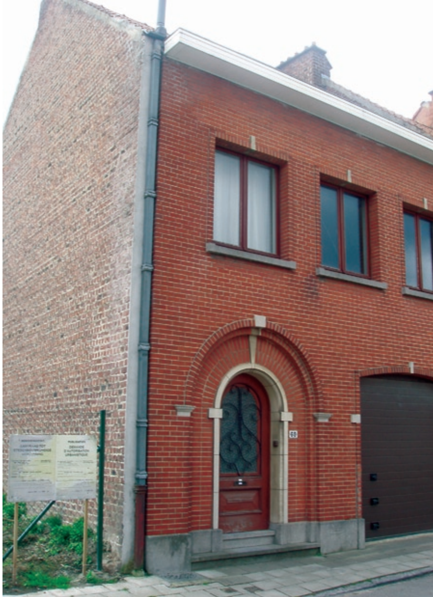
DE WONING IN HAAR HUIDIGE STAAT. LINKS DE GEVEL WAAR TEGENAAN GEBOUWD ZAL WORDEN.
